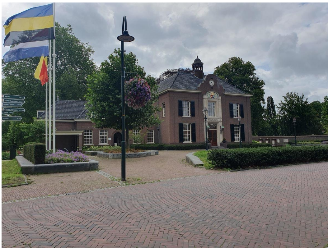
Afbeelding 3; Raadhuis Heerde na renovatie opnieuw geschouwd.
