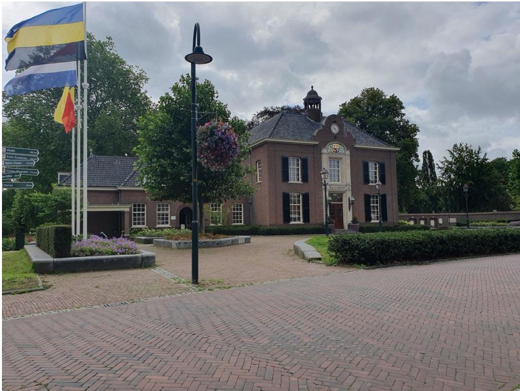
Afbeelding 3; Raadhuis Heerde na renovatie opnieuw geschouwd.
