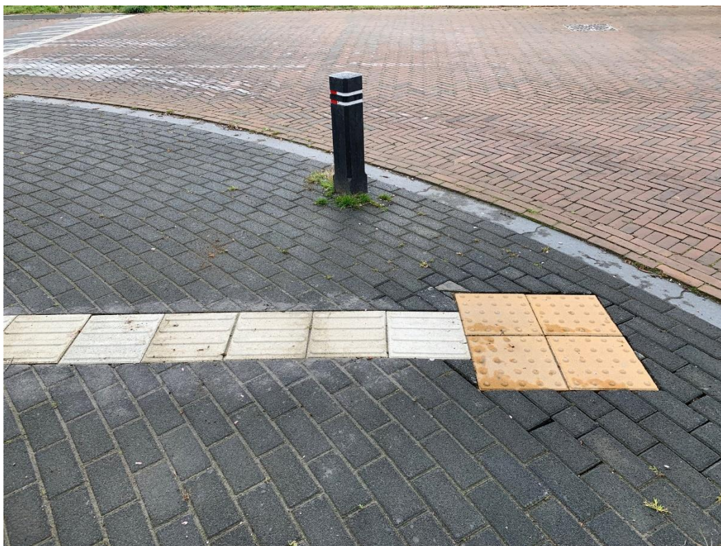
Afbeelding 8: Blindengeleidelijnen (strepen) met waarschuingsvlakken (noppen).
